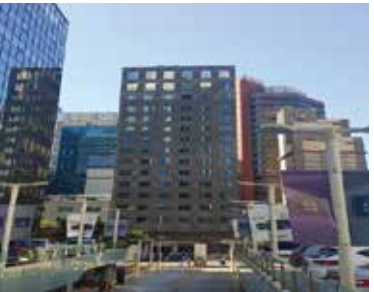
명동크라운 호텔 리모델링 CM
