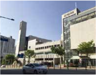
이룸교회 증축공사 감리
